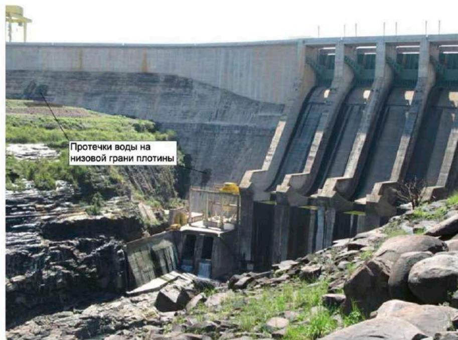
Рисунок 6.2.1 - Плотина из укатанного бетона.
