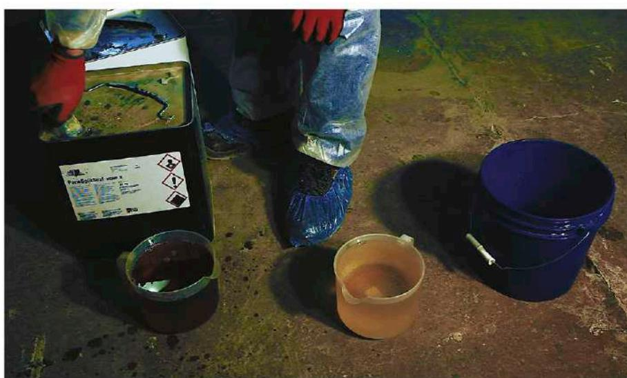
*Рисунок 7.2.30 – Дозирование компонентов смолы.*
