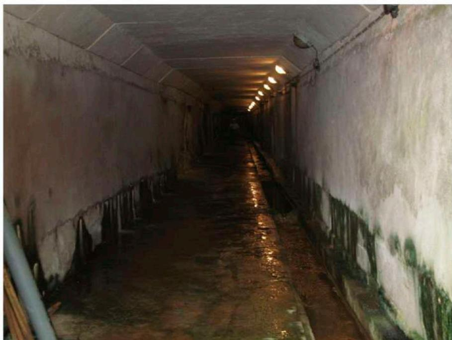
Рисунок 5.1 - Фильтрации воды в потернах бетонной плотины.
