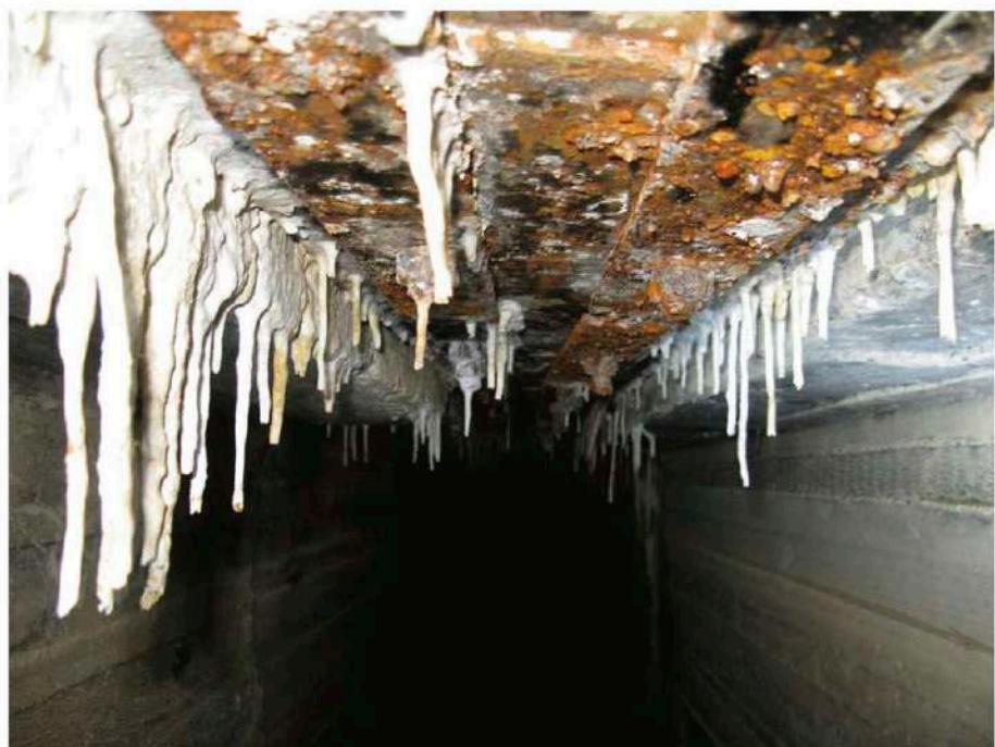
Рисунок 5.2 - Фильтрация воды через потолочное уплотнение деформационного шва с выносом гидроксида кальция и образованием «сталактитов» в соединительном коридоре между смотровыми шахтами со стороны верхнего и нижнего бьефов здания ГЭС.
