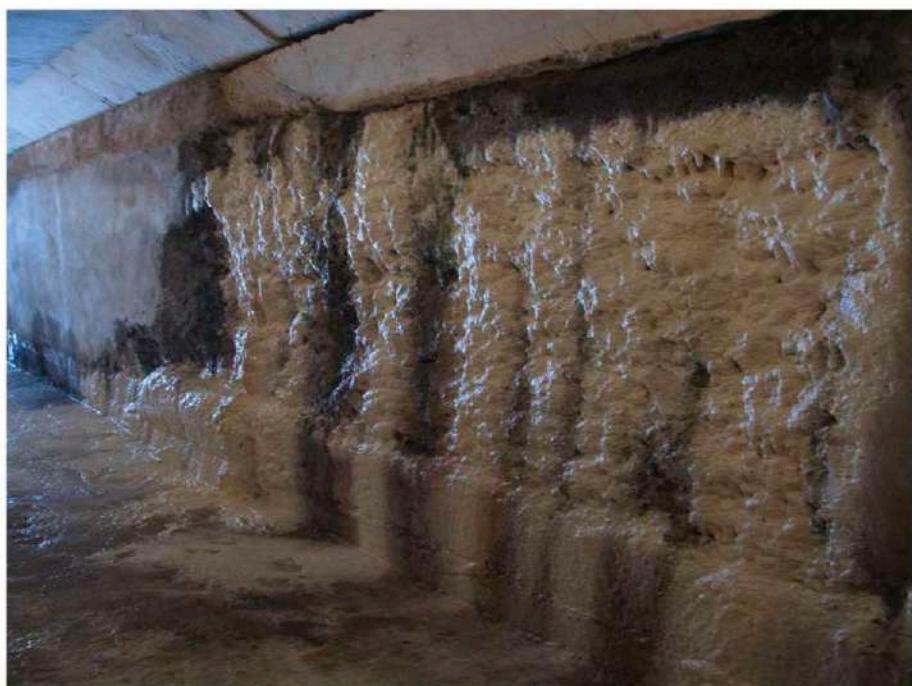
Рисунок 5.5. - Фильтрация воды через шов бетонирования между стеной и перекрытием потерны.
