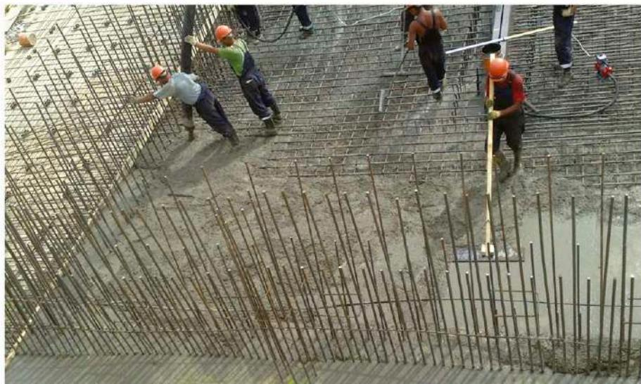
Рисунок 7.1.3 - Укладка бетонной смеси.
